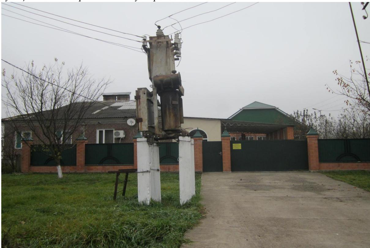
***Трансформаторная подстанция – 100 кВт. ул.Калинина. Трансформатор ржавый. Замаслен. Надписи отсутствуют.***
