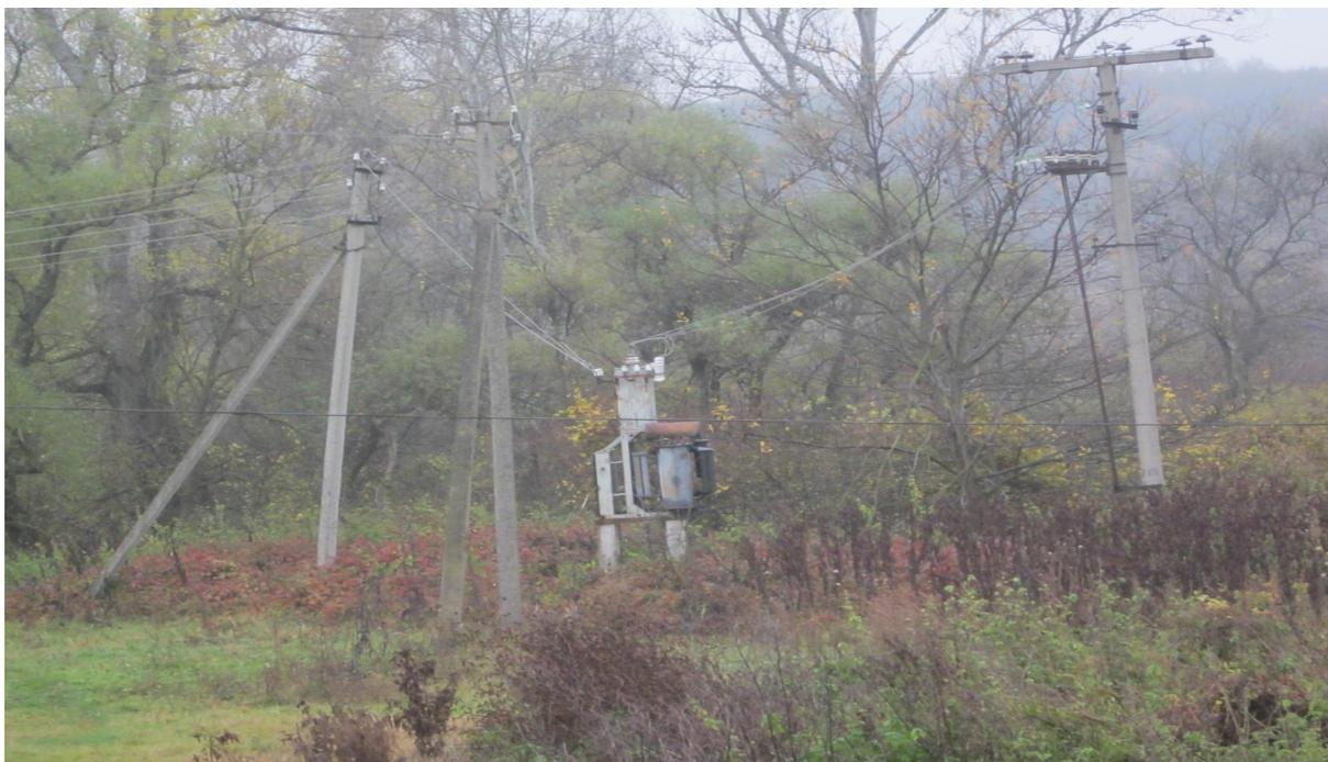
***Трансформаторная подстанция – 100 кВт. ул.Лизы Чайкиной. Замаслен.
